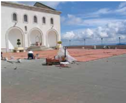
I lavori di pavimentazione del piazzale
