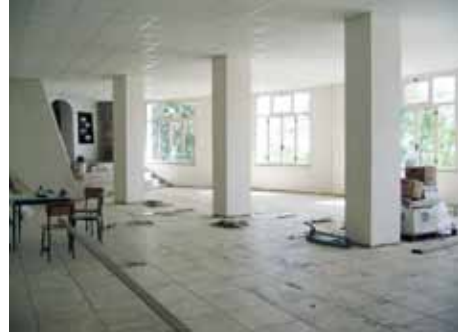
La sala del pellegrino durante i lavori
