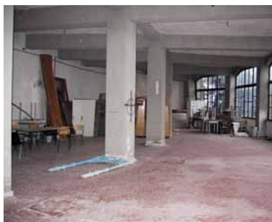
La sala del pellegrino prima dei lavori
