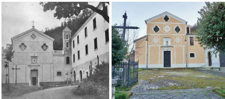
Chiesa di Santa Maria della Libera, prima e dopo il sisma del 1980.
