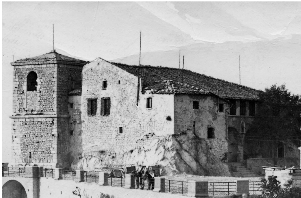
Vecchia immagine del Santuario del SS. Salvatore prima che sopraelevassero il campanile
